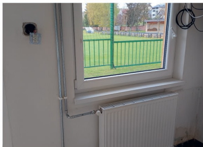
Rekonstrukce šatní po povodni
