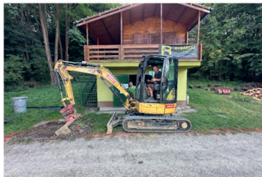
Úprava plochy před rybářskou baštou
