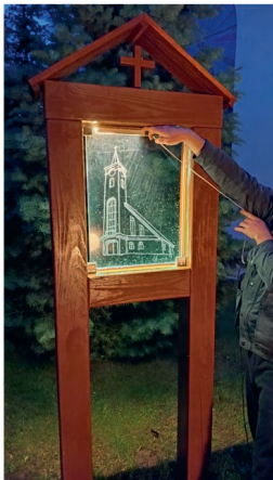
Zkouška osvětlení vyleptaného skla po setmění
